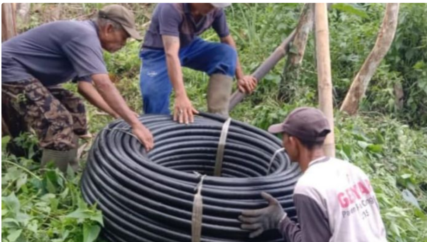
Progres pekerjaan pompa hidram pertanian Desa Panji Anom
